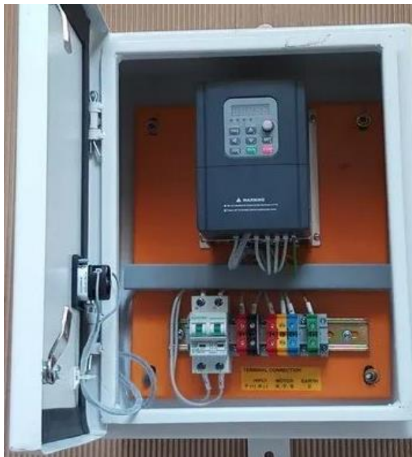
चित्र ५: कन्ट्रोलर बक्स र VFD पम्प कन्ट्रोलर
